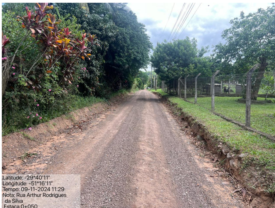
Foto 2: Vista Geral - Estaca 0+050
