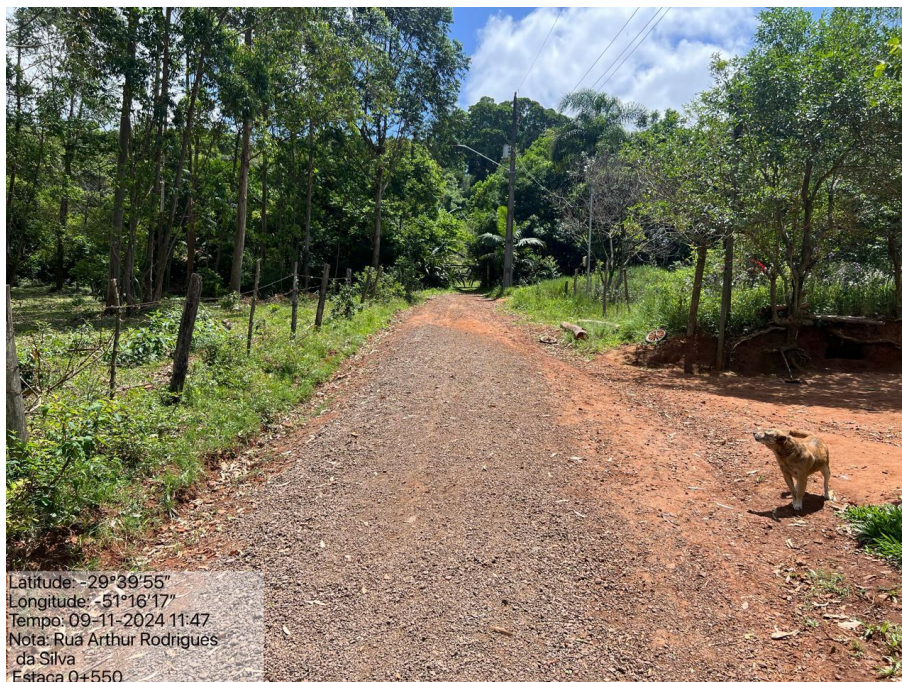
Foto 12: Vista final - Estaca 0+550
