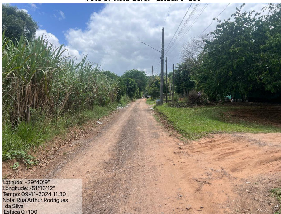
Foto 3: Vista Geral - Estaca 0+100
